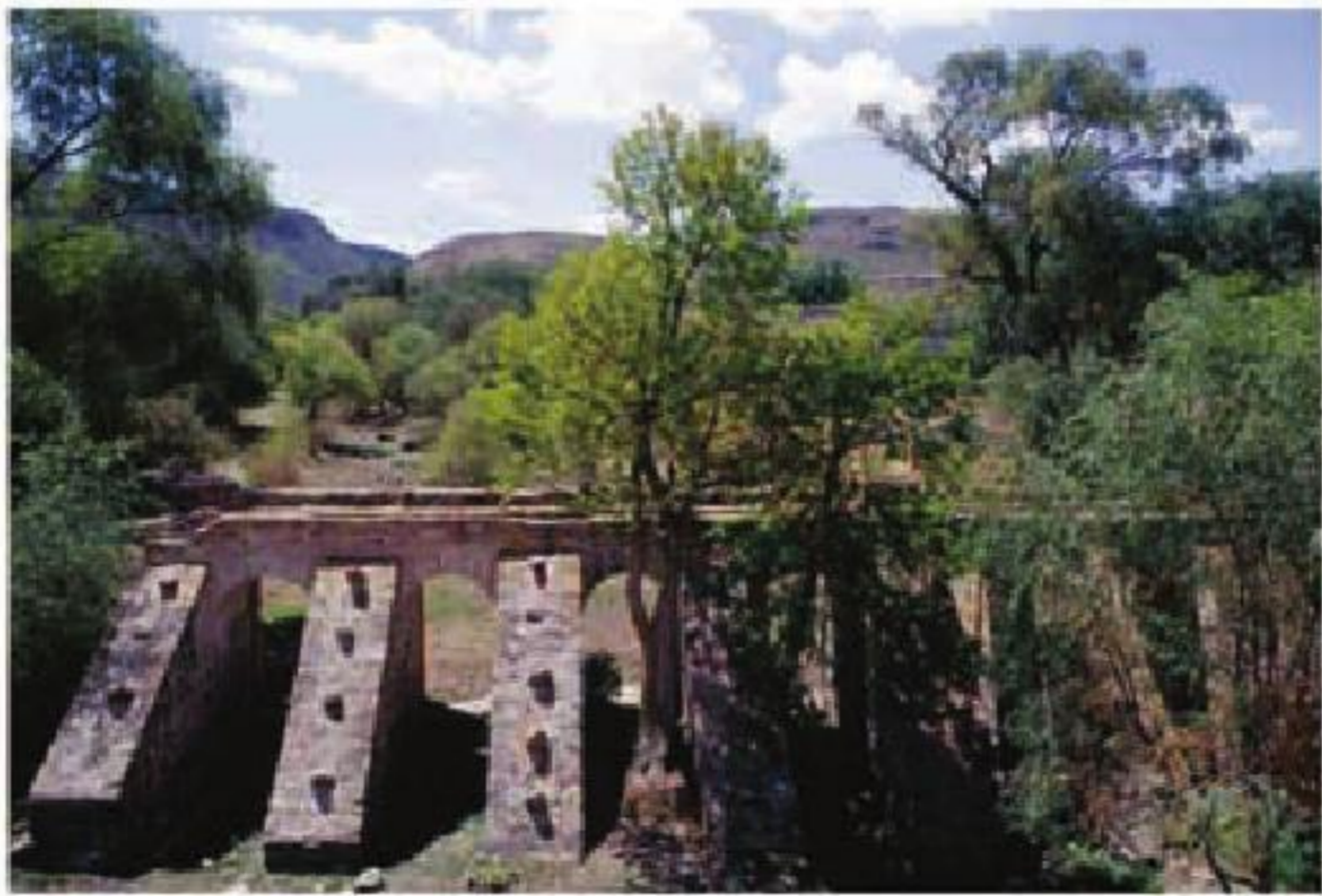
Acueducto de Rincón de Romos, Aguascalientes
